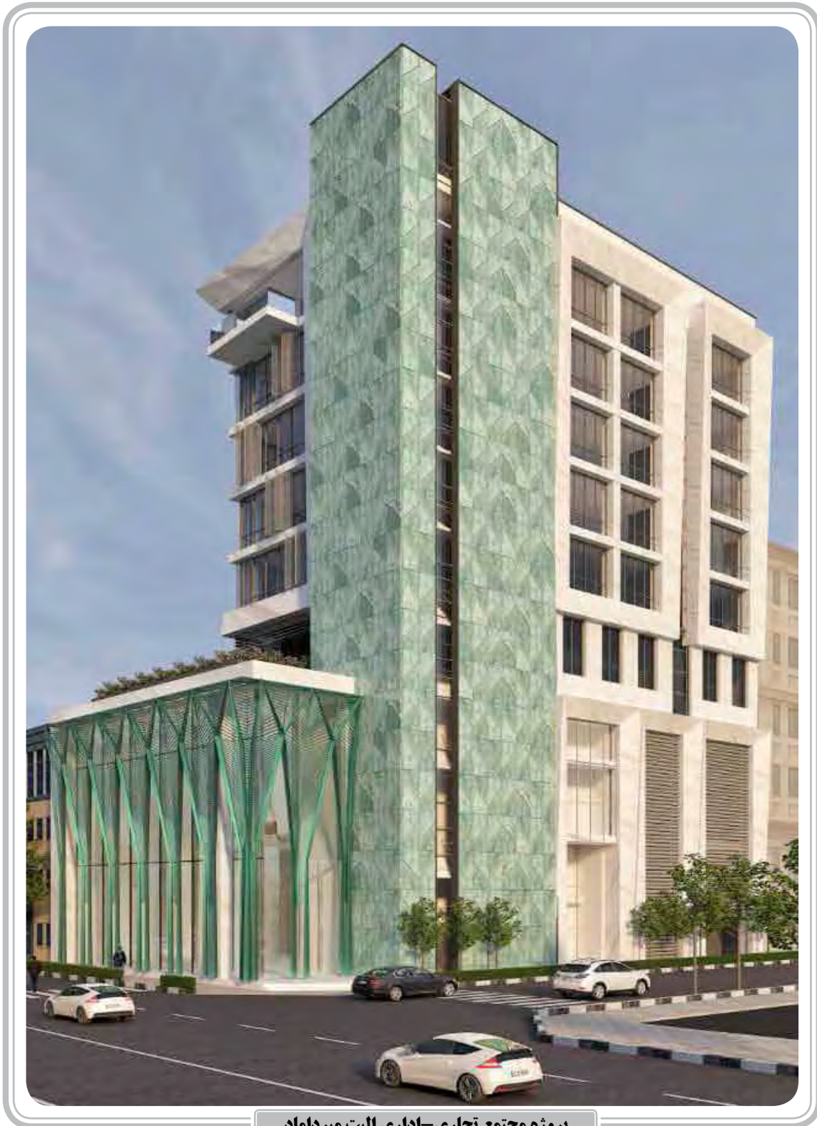
پروژه مجتمع تجاری-اداری البت میرداماد
