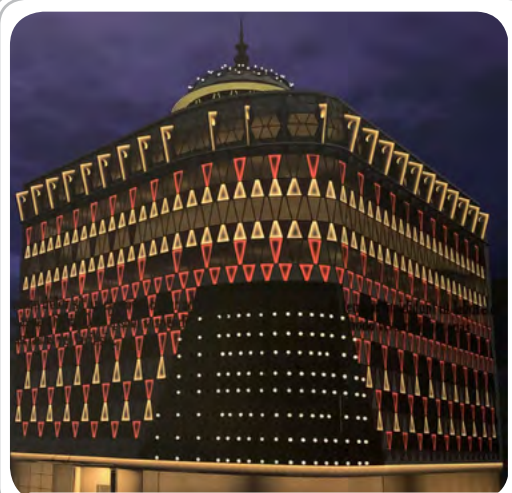
پروژه مجتمع تجاری کلسرخ شوش
