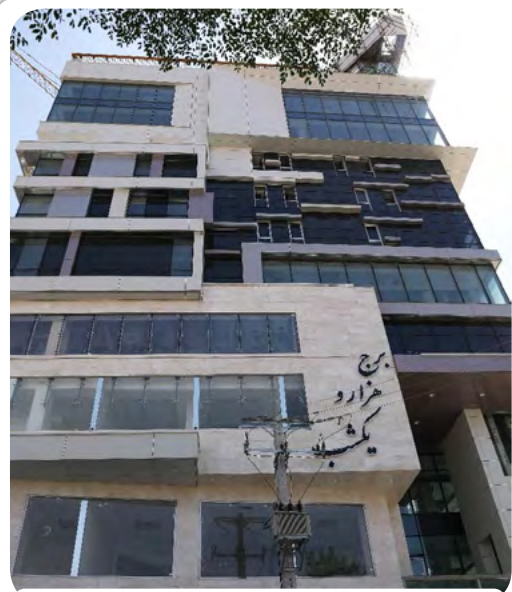
پروژه برج تجاری-اداری هزار و یک شب کرمان
